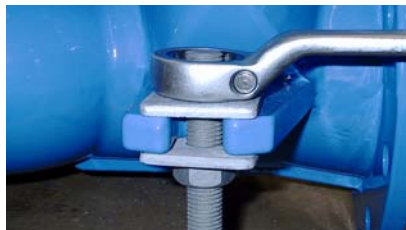
Fig. 2: Mutter på overside trekkes først til med 50 Nm
