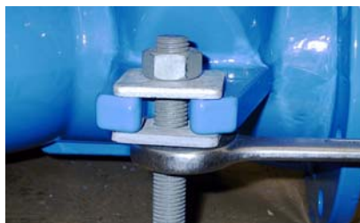
Fig. 3: Mutter på underside trekkes så til med 50 Nm
