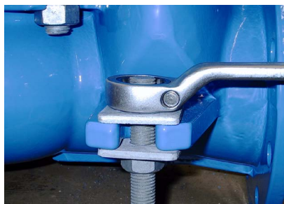
Fig. 4: Som avslutning på montering av enheten trekkes muttrene til med 150 Nm på oversiden
